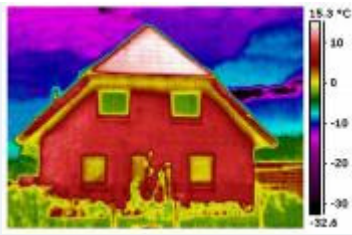
Thermographie eines Wohnhauses (Quelle: dpa-report / Hensel)
